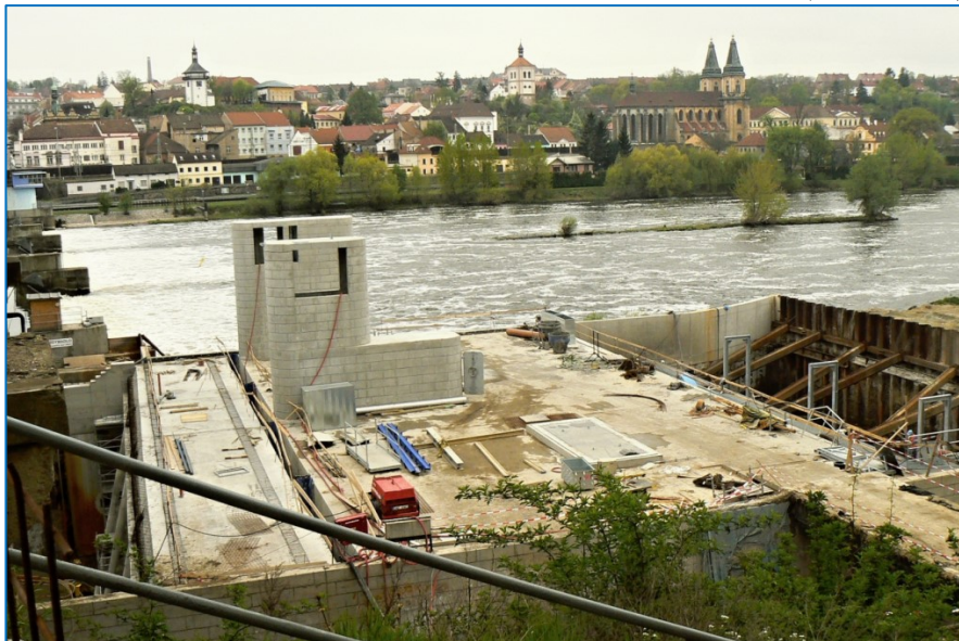
Stavba malé vodní elektrárny v roce 2013
